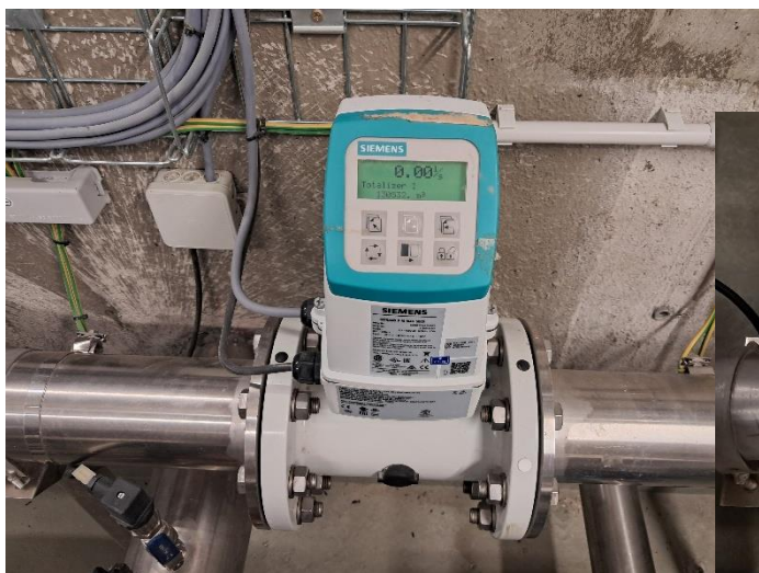
Obrázek 6 Průtokoměr na nátoku; vodoměr na výtlačku
